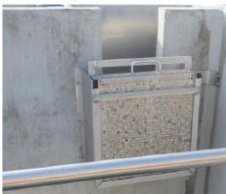
Figura 5: Filtro poliuretano, impianto di trattamento in continuo delle acque meteoriche
